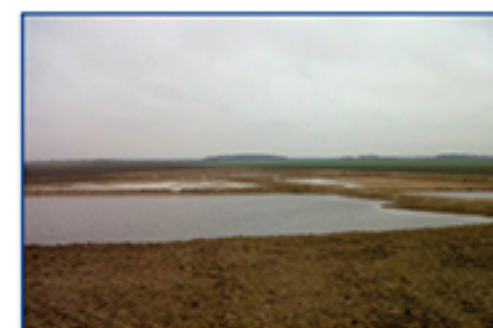
Vue des bassins d'infiltration
