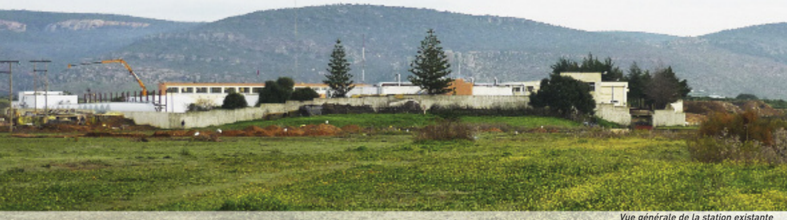
Vue générale de la station existante
