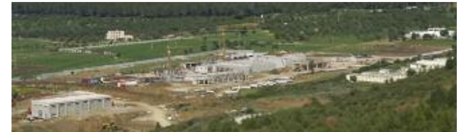
Vue de la station de pompage d'eau brute réalisée & de l'usine de traitement en cours de travaux.
