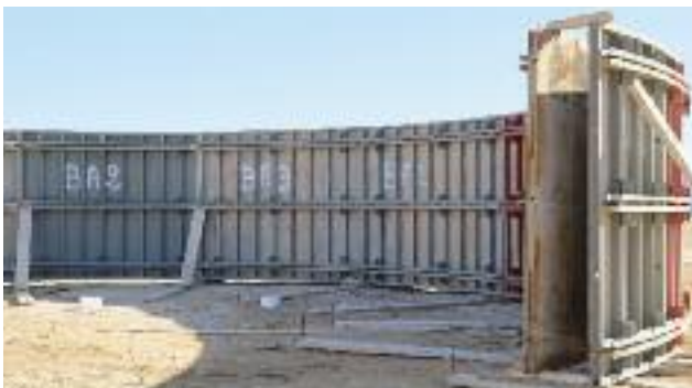
Coffrage des clarificateurs.
