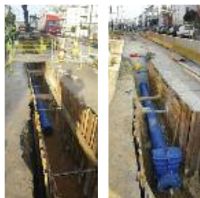
Pose en tranchée de la nouvelle canalisation de distribution DN300.
