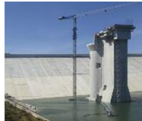
Prise eau brute barrage Oued Martil et barge provisoire.
