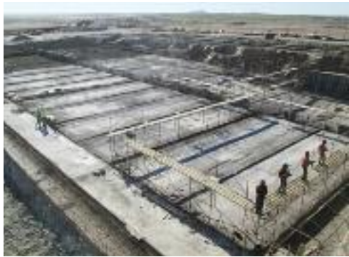
Radiers des filtres à sable.
