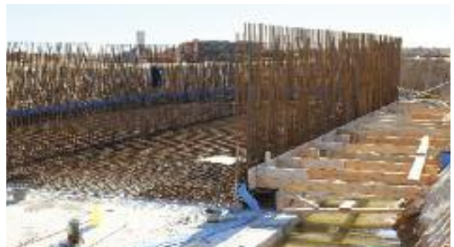
Ferrailage des bassins aérés.
